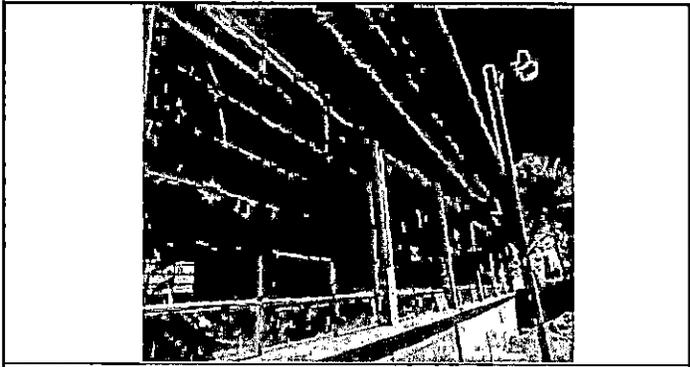
**Foto 6:** Vidrios en mal estado y falta de balconización de 14 ventanas del edificio del aula 1, aula 2, dirección y bodega.
